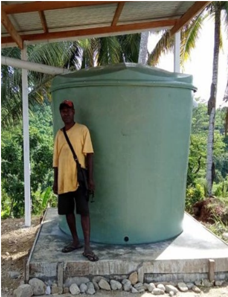
Nombre de réservoirs d'eau installés en PNG grâce au Bonus Chocolat.
